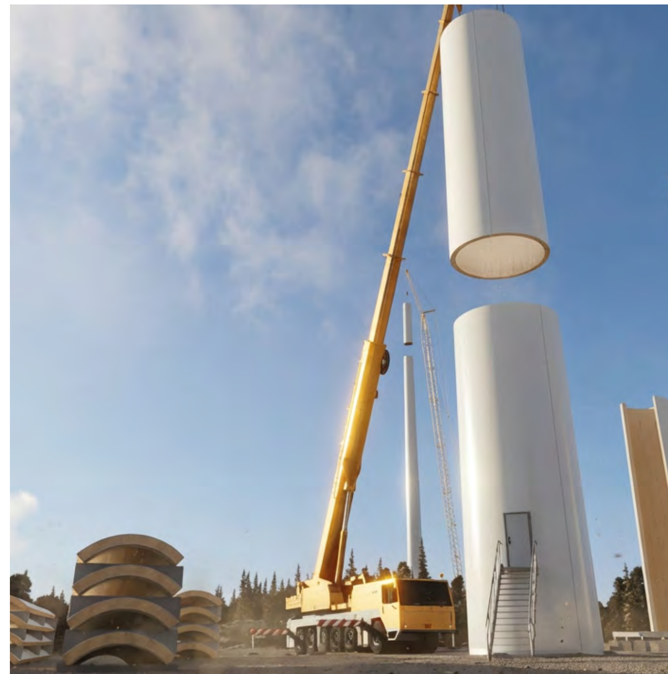
Montaje de torre eólica en madera desarrollada por Modvion.
